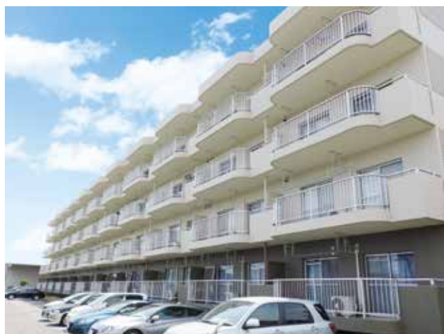
AGC旭硝子(株)市原住宅 「ボンフロンGT WR100-SR工法」
